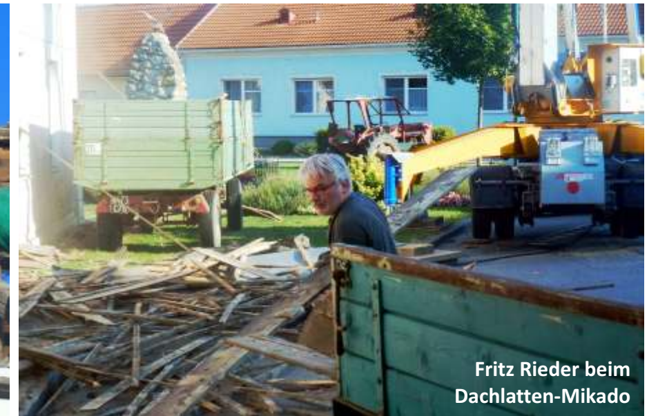
Beni Partik beim Dachabräumen
